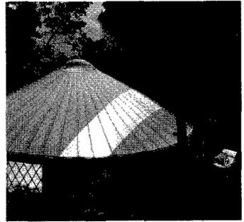
広大な大草原で暮らす遊牧民の知恵が活かされたヤーツは、空気力学的に優れた強風にも充分耐えられる。また、耐雪強度を考慮した設計に加え、難燃性・耐紫外線性のある特殊カバーで覆われている。そして、NASAが開発した特殊保温シート「アストロ・foil・インシュレーション(オプシオン)」を外部カバーの下に挟むだけで、冬暖かく夏涼しく、フルシーズン快適なスペースが得られる。その他にも、天頂部の透明なスカイライト(テクリル製のドーム)は開閉自在なので、星空を楽しんだり、空気の入れ換えもできる。天井部は虹状の半透明ソ
