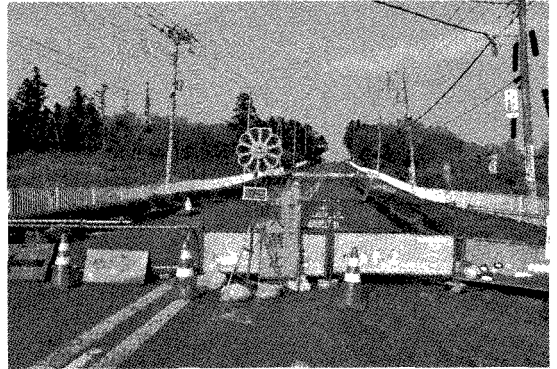
写真19 通行止めとなった国道354号線
