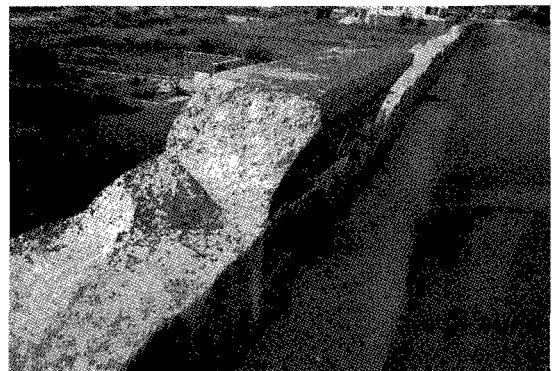
写真5 防波堤の断面図
