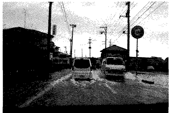
写真3 地盤沈下による道路の冠水
